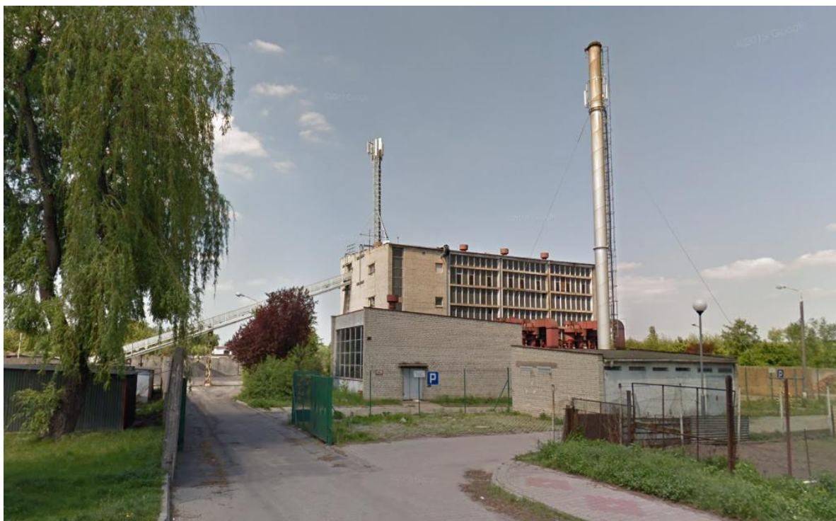
Obecna kotłownia przy ul. Źródłana 5 w Luboniu
