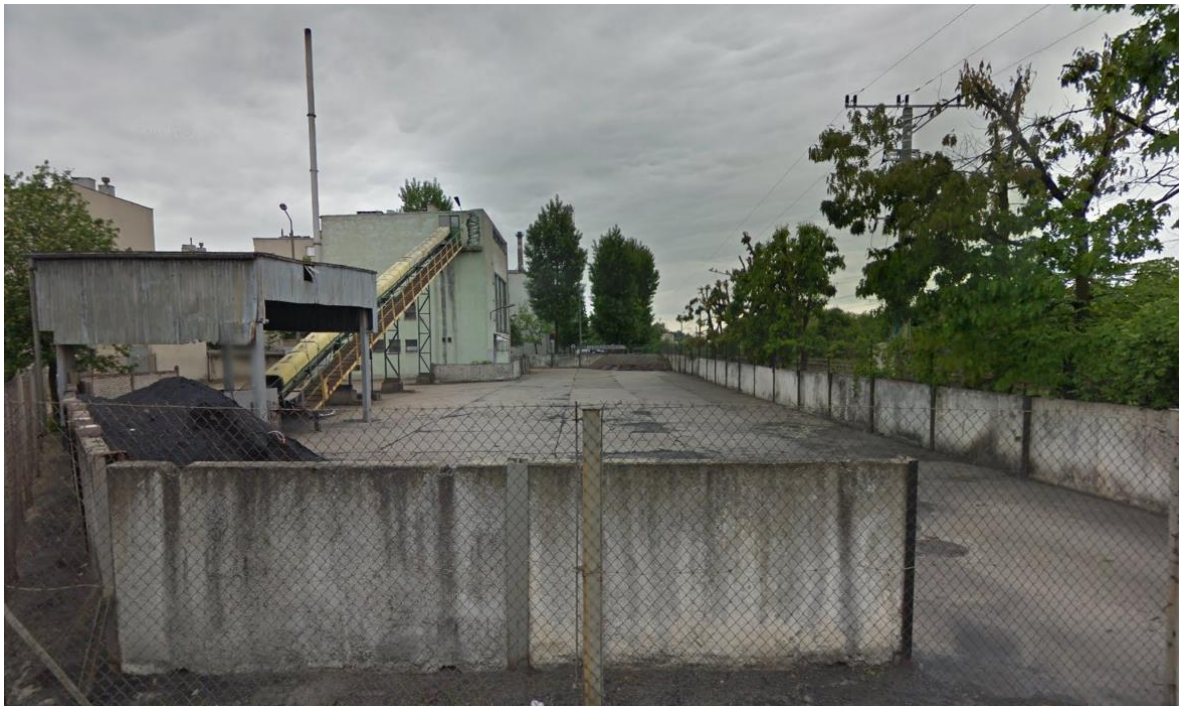
Kotłownia przy ul. Sowinieckiej 47c w Mosinie
